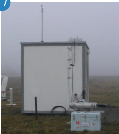
▲ Dispositif expérimental de prélèvement des aérosols et des gouttelettes de brouillard.
